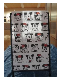
柄物クロス張り合わせ 職種：内装仕上げ
