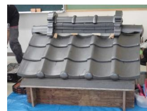
屋根瓦 職種：かわらぶき
